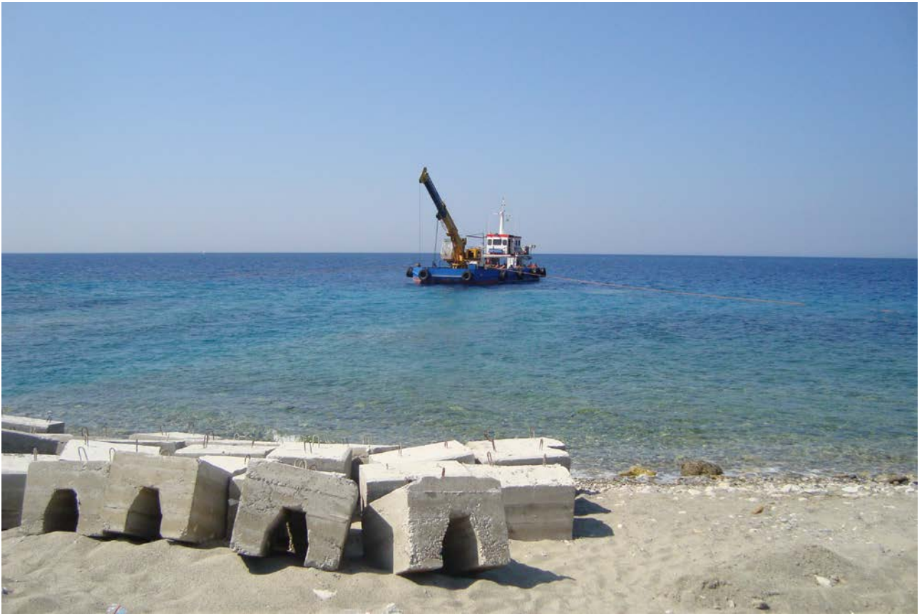
LA POSA DELLA CONDOTTA A MARE
